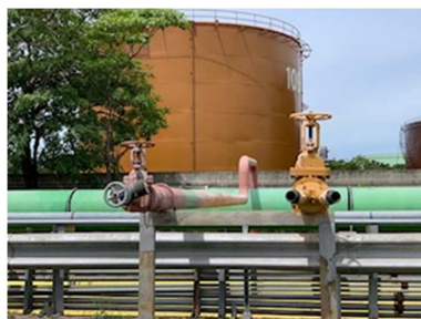
รูปที่ ข-32 หัวจ่ายน้ำดับเพลิง Hydrant ติดตั้งบริเวณรอบนอกของถังเก็บน้ำมัน
