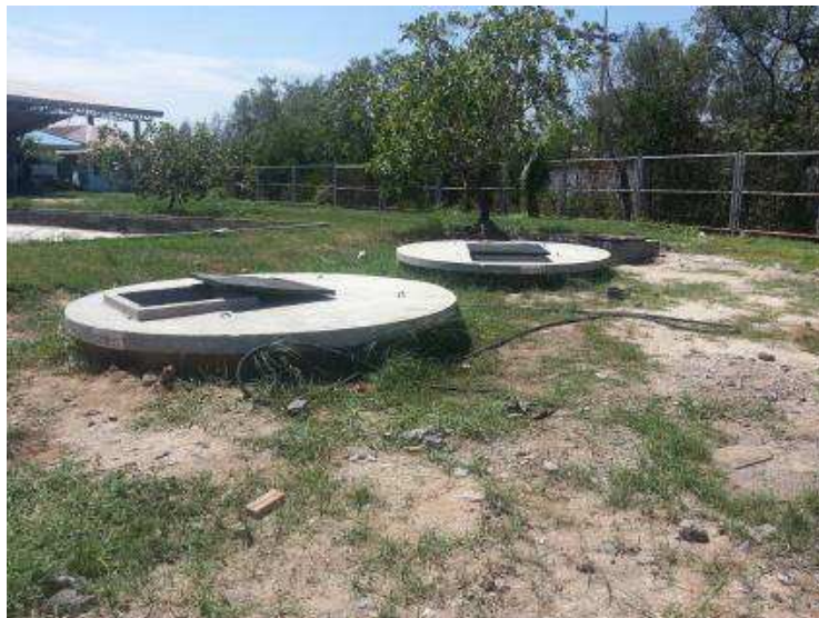
รูปที่ ข-19 บ่อพักน้ำทิ้งจากระบบ API Separator
