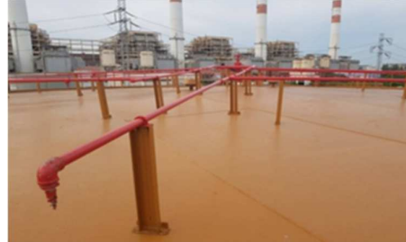
รูปที่ ข-29 ระบบกระจายน้ำดับเพลิงแบบอัตโนมัติ
