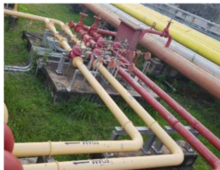
รูปที่ ข-31 ระบบหัวกระจายน้ำดับเพลิงแบบอัตโนมัติประเภทระบบเปิด
