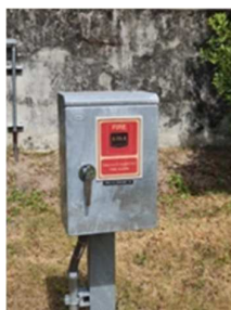
รูปที่ ข-33 อุปกรณ์แจ้งเตือนเหตุเพลิงไหม้และอุปกรณ์ตรวจจับ
