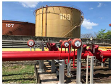
รูปที่ ข-29 ระบบกระจายน้ำดับเพลิงแบบอัตโนมัติ
