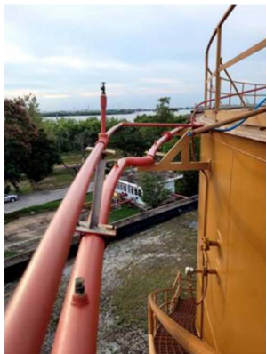
รูปที่ ข-28 ระบบ Water Spray ติดตั้งที่ถังเก็บน้ำมันทุกถัง
