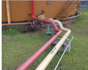
รูปที่ ข-30 ระบบหัวกระจายน้ำดับเพลิงแบบอัตโนมัติ ด้วยสารละลายโฟม
